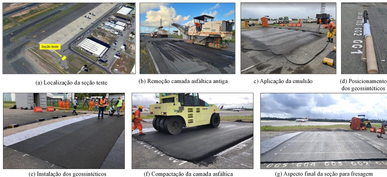
Figura 2. Construção das seções experimentais de teste [adaptado de: Souza, 2024].
